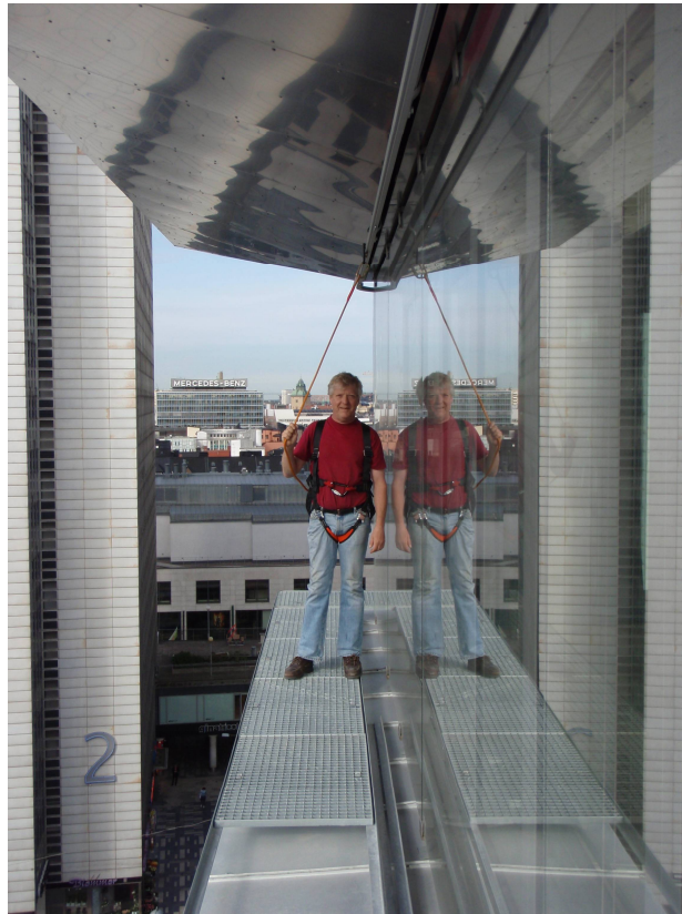
Fig. 3. Securail fixé sur structure métallique
